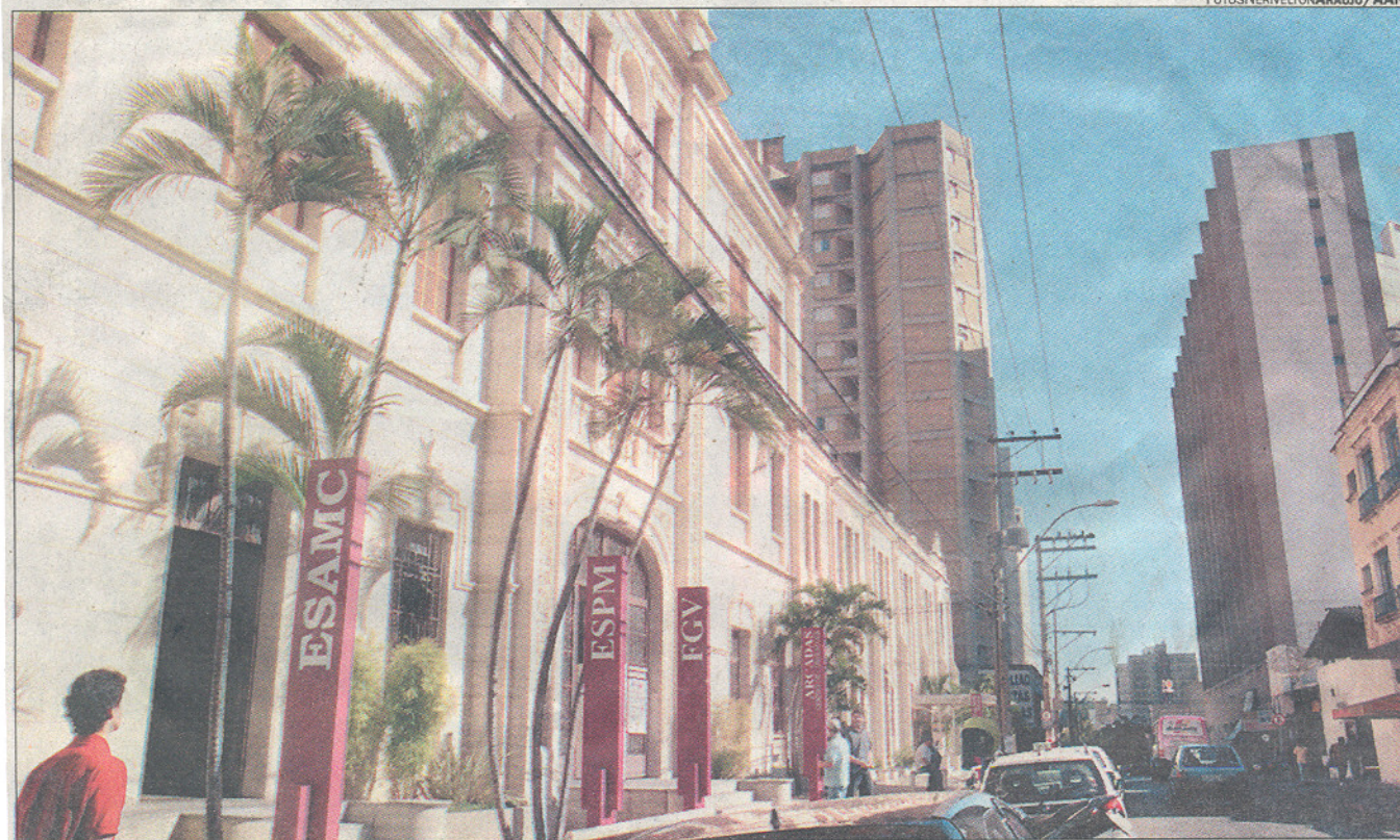
O Arcadas, na José Paulino: centro de convenções de alta tecnologia preserva traços originais do prédio
