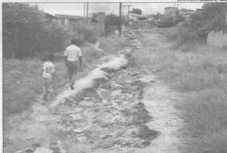
Erosão em rua do Valença 2: 15 dias sem coleta de lixo
