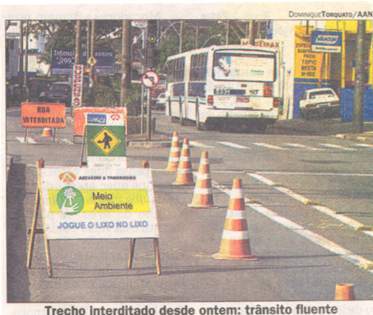
Trecho interditado desde ontem: trânsito fluente
