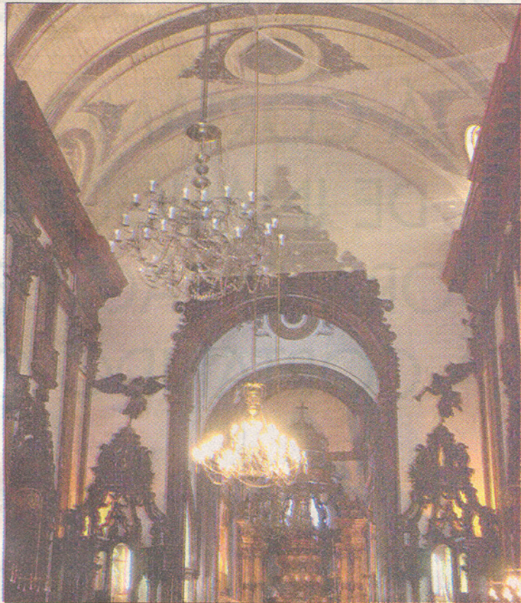
Em um primeiro momento, o telhado e o forro serão reparados
