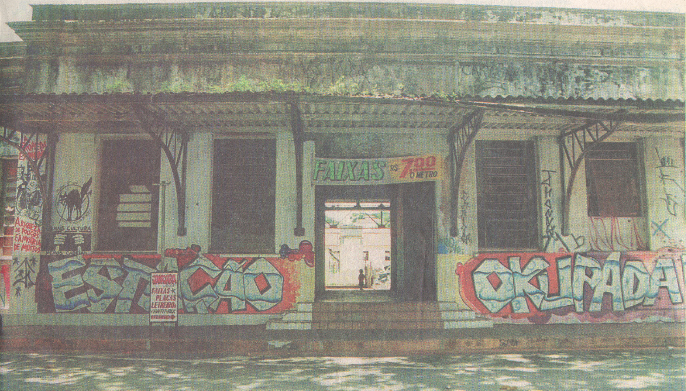
Entrada principal da Estação Guanabara, em Campinas, que foi uma das mais movimentadas da cidade no início do século 20, e agora está ocupada por moradores que promovem uma cultura alternativa
