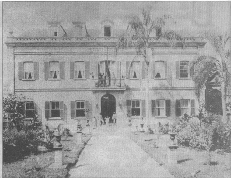
Fachada do Colégio Culto à Ciência: sinais do descaso
