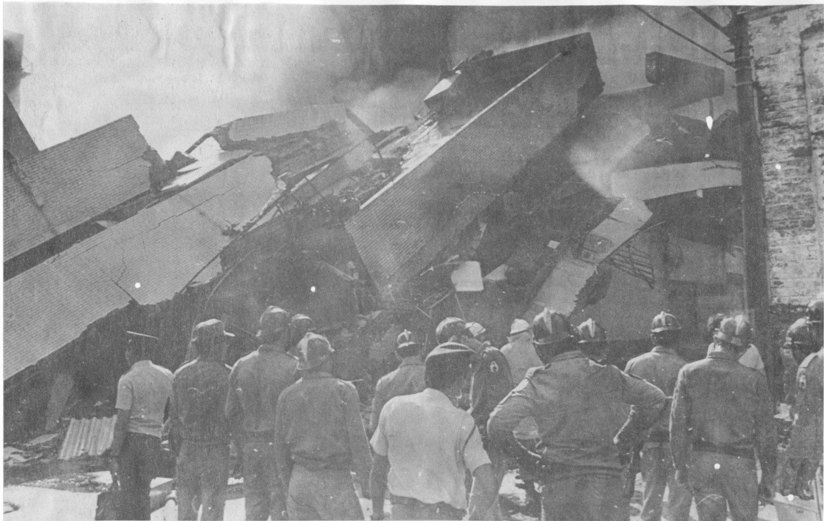
Paredes laterais ruíram, atingindo diversas pessoas que estavam no prédio
