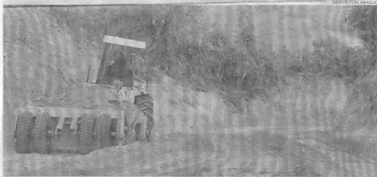
Vista de uma das estradas de acesso ao aterro: mata protegida por decreto federal
