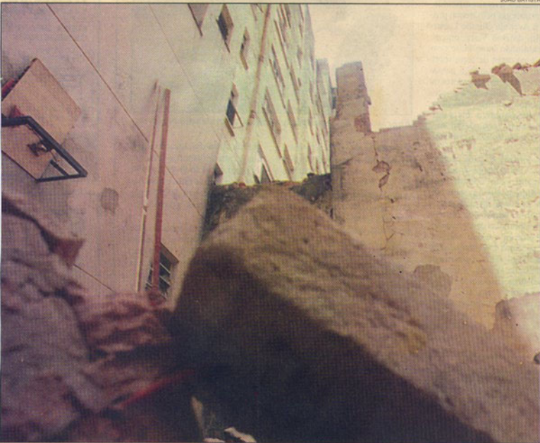
Escombros da parede dos fundos do casarão: medidas de segurança tornam trabalhos lentos
