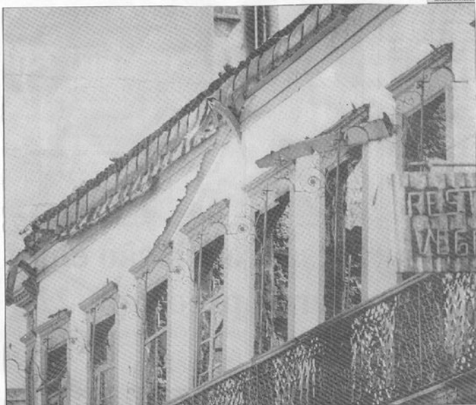
Fachada destruída no incêndio; trabalho de demolição será acompanhado por técnicos do Instituto de Pesquisas Tecnológicas
