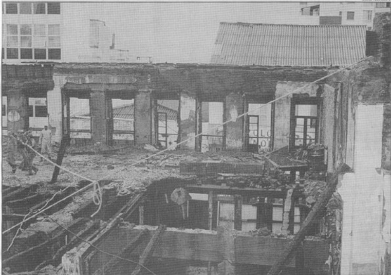
Bombeiros fazem a amarração da parede comprometida: Prefeitura publica edital para escolher empresa que fará escoramento
