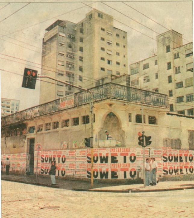
Fachada do Solar do Visconde de Indaiatuba; tombamento pelo Condepacc não permite que obra em ruínas seja demolida
