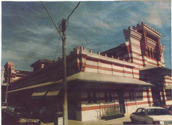
O prédio do Mercado, entre a Benjamin Constant e Barreto Leme: prédio já abrigou uma estação de trem
