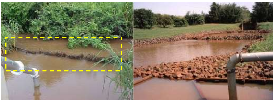
Figura 129: Sistema de pré-filtragem: tela (esquerda) e bacias de sedimentação com barreiras de pedra (direita).
