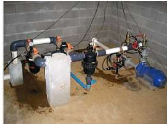
Figura 123: Esquema de cabeçal de controle para irrigação localizada (esquerda) e exemplo de um cabeçal montado em propriedade rural (direita) (Fonte: ANTUNES, 2016).
