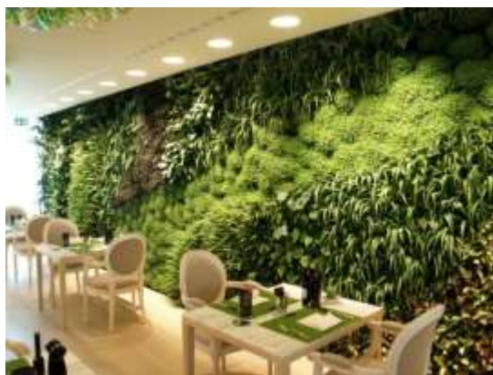
Figura 233: Exemplo de muro verde projetado para área interna irrigada por gotejamento (ARTMAISON, 2017).
