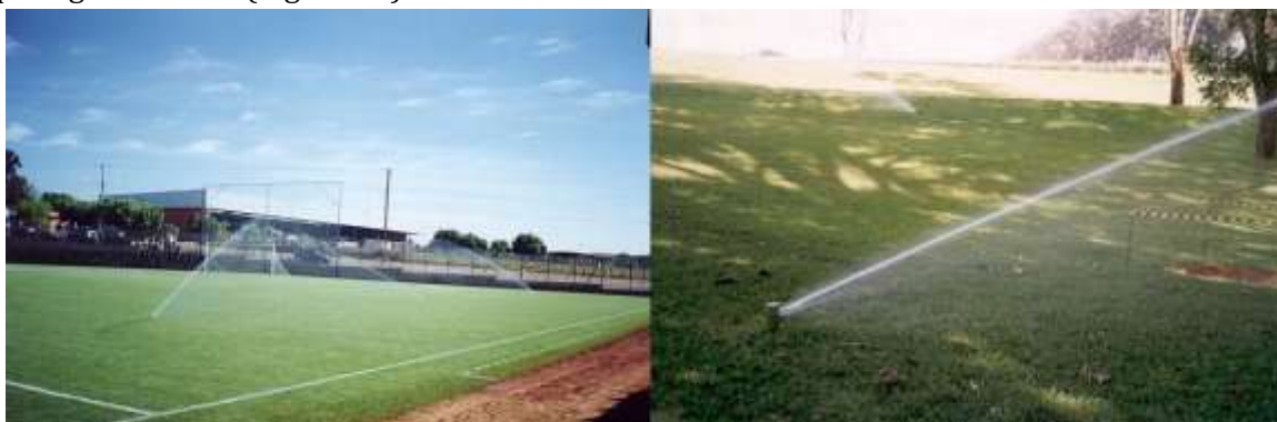
Figura 68: Spray escamoteável em operação quando pressurizado (Fonte: HERNANDEZ, 2010).
