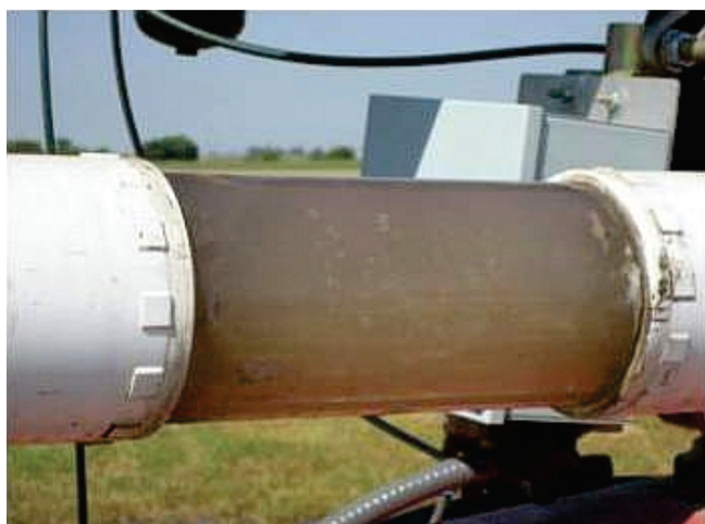
Figura 22. Modelo de visor de acrílico utilizado para inspeção da água de retrolavagem. (Fonte: University of Califórnia, 2013)
