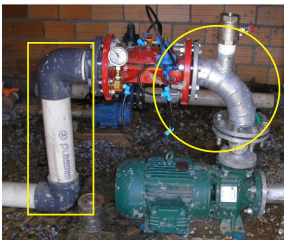
**Figura 38.** Exemplo de aplicação de curvas de raio curto em PVC (soldável) e de raio longo em aço zincado (flangeado e em gomos) em um sistema de bombeamento de irrigação. (Fonte: ANTUNES, 2006)
