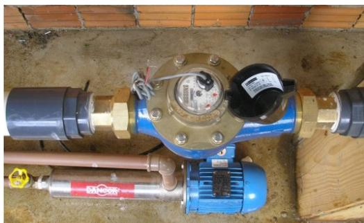
**Figura 90.** Detalhe de uma válvula volumétrica instalada em um sistema de irrigação.
