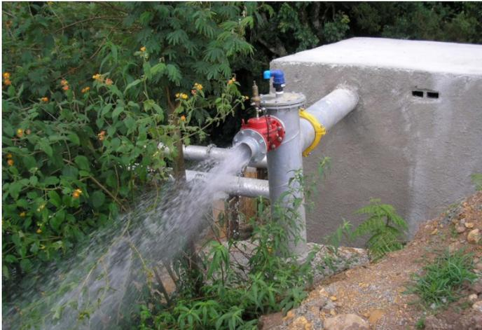
**Figura 94.** Exemplo de válvula de alívio operando em um sistema de irrigação.
