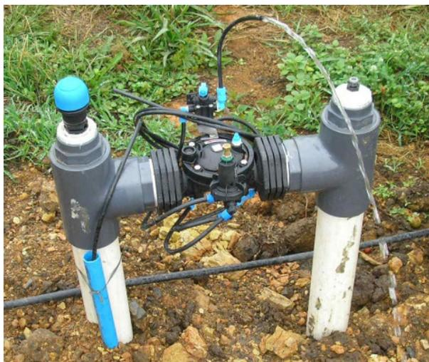
**Figura 108.** Cavalete de distribuição em irrigação localizada com válvula operada por tubos de controle. (Fonte: ANTUNES, 2006)
