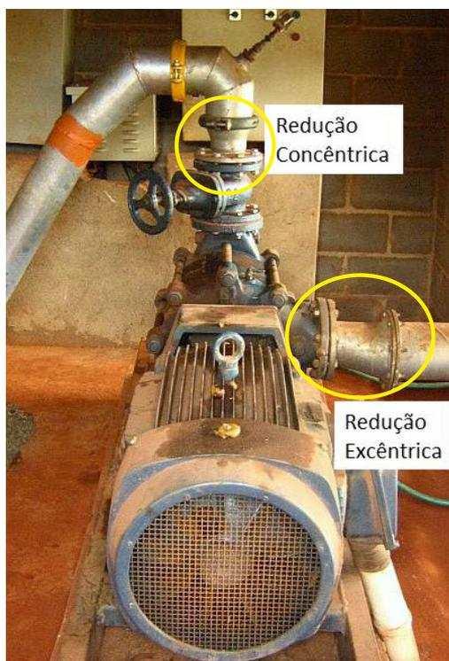
**Figura 43.** Montagem de uma bomba centrífuga com destaque para a redução concêntrica e excêntrica.
