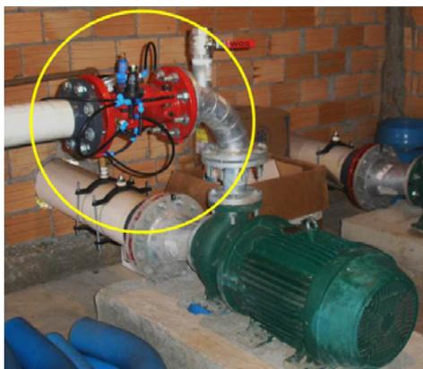
**Figura 89.** Detalhe da instalação de uma válvula de controle com abertura lenta.
