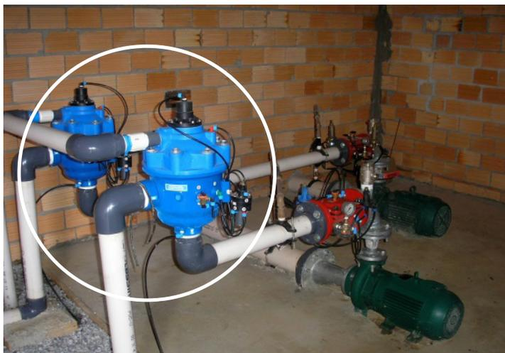
**Figura 5.** Exemplo de um cabeçal de controle de irrigação localizada, com dois filtros de disco. (Fonte: ANTUNES, 2006)
