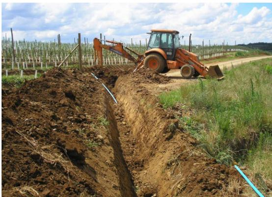
**Figura 128.** Exemplo de escavação de valeta com baixa profundidade. (Fonte: ANTUNES, 2006)
