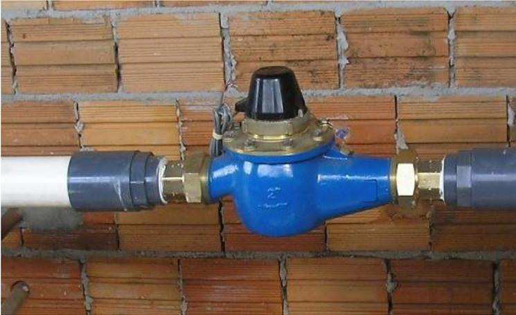
**Figura 44.** Exemplo de redução de diâmetro por bucha para instalação de válvula volumétrica em linha de recalque. (Fonte: ANTUNES, 2006)
