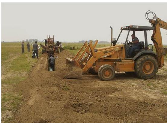
**Figura 132.** Valeta de tubulação no processo de cobertura ou aterramento.
