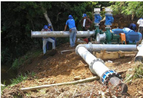
**Figura 116.** Detalhe da montagem da tubulação de sucção pela sua parte horizontal. (Fonte: ANTUNES, 2006)
