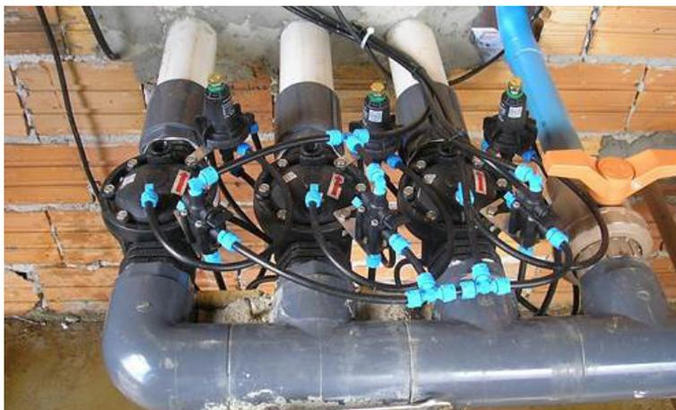
**Figura 2.** Exemplo de tubulações de controle conectando válvulas em um sistema de irrigação. (Fonte: ANTUNES, 2006)
