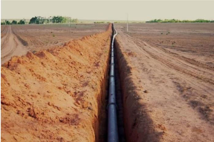
**Figura 101.** Detalhe da montagem de uma adutora enterrada de pivô central. (Fonte: FOCKINK, 2014)
