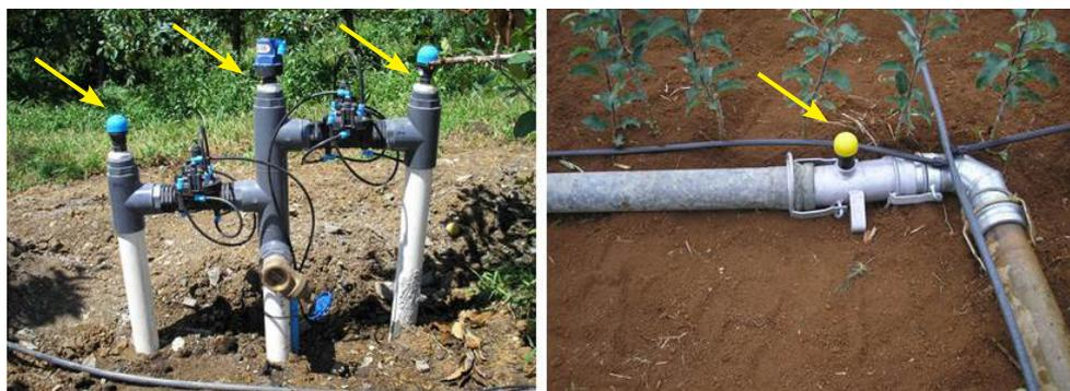
**Figura 125:** Exemplos de instalação de ventosas em sistemas de irrigação. (Fonte: ANTUNES, 2006)
