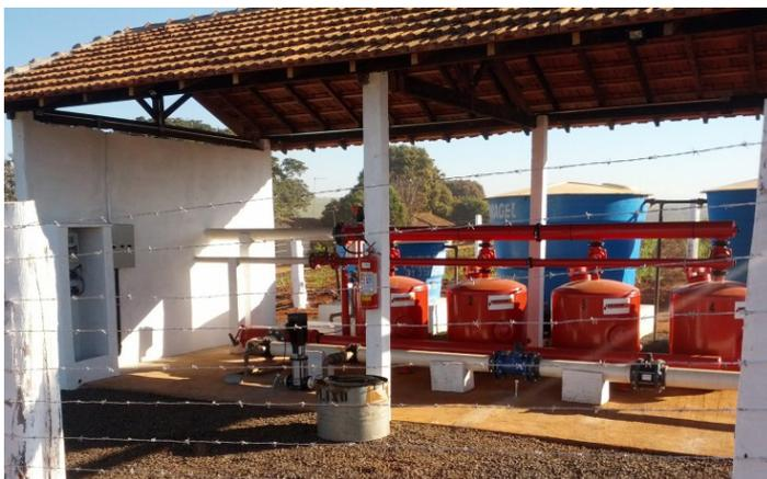
**Figura 126.** Exemplo da instalação de um cabeçal de controle em irrigação localizada.
