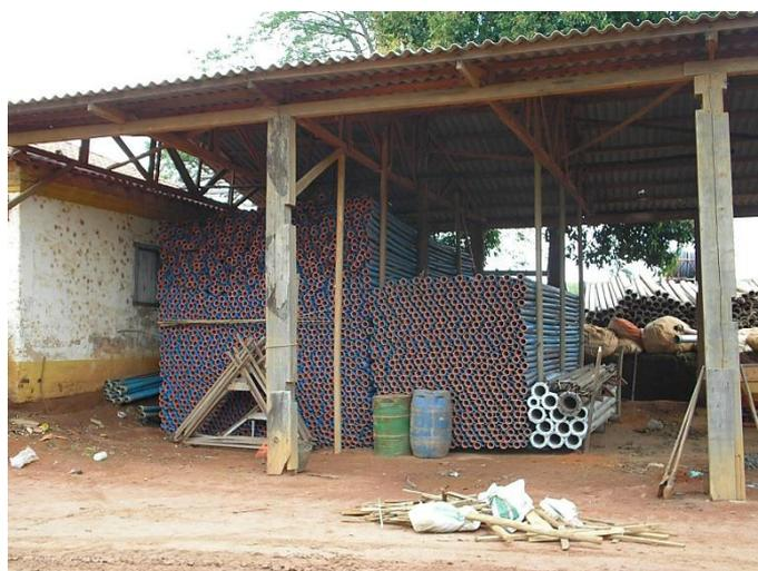
**Figura 134.** Exemplo de armazenamento de tubos de PVC em pilhas com alturas acima do valor recomendado de 1,5m.
