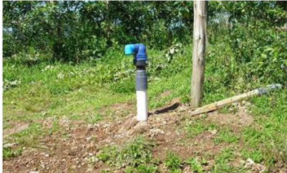
**Figura 95.** Exemplo de uma válvula ventosa instalada em um sistema de irrigação por gotejamento com a tubulação enterrada. (Fonte: ANTUNES, 2006)
