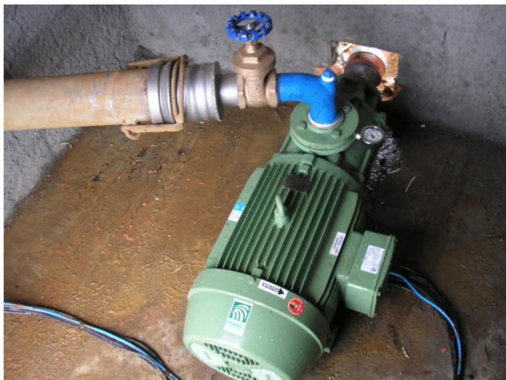
**Figura 70.** Emprego de uma válvula gaveta em conjunto de bombeamento elétrico (Fonte: ANTUNES, 2006).
