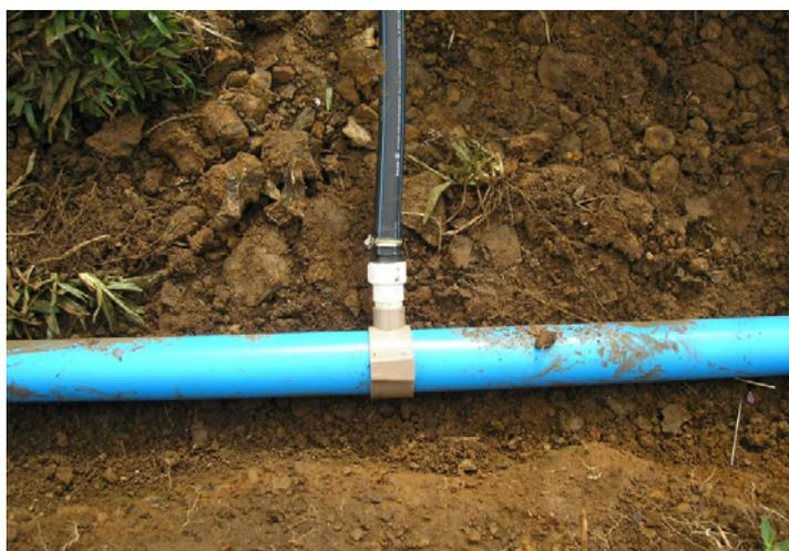
**Figura 40.** Exemplo de conexão do tipo colar de derivação (marrom) ligando tubos de PVC (azul) com PE (preto). (Fonte: ANTUNES, 2006)
