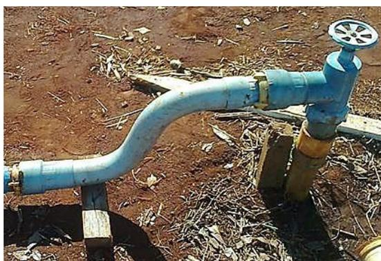
**Figura 53.** Válvula de linha montada no campo com a curva de nivelamento acoplada à curva de derivação.
