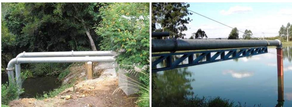
**Figura 119.** Exemplos de sistemas de sustentação da tubulação de sucção: à esquerda, por pilar de concreto e à direita, por treliça metálica em balanço.
