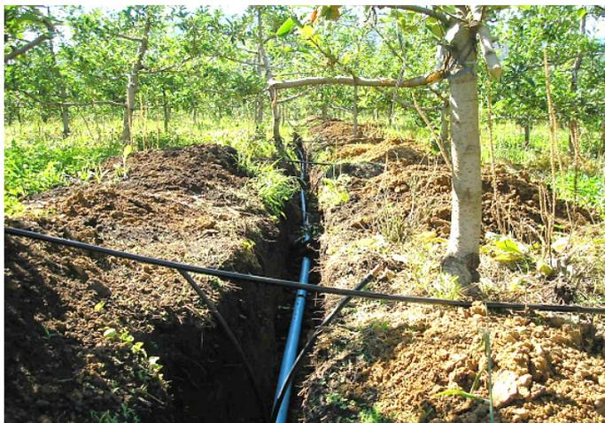
**Figura 10.** Detalhe de uma tubulação de PVC que vai operar enterrada em irrigação localizada.
