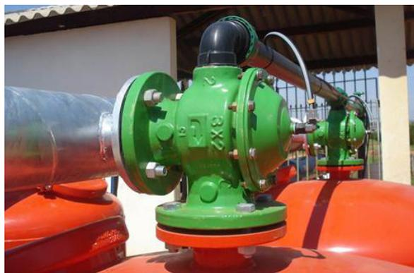
**Figura 91.** Exemplo de válvula de retrolavagem instalada sobre filtros de areia de um sistema de irrigação.
