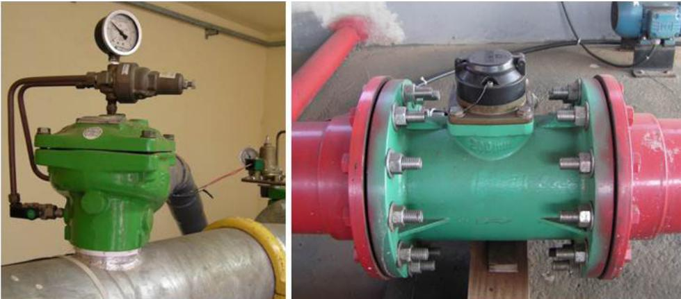
**Figura 135.** Exemplos de instalação de manômetros e válvula volumétrica para monitoramento da pressão e vazão, respectivamente, em sistemas de irrigação.
