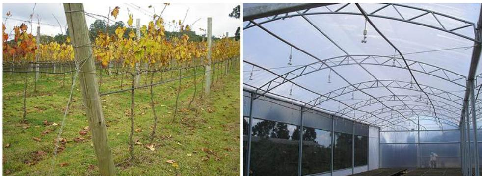
**Figura 110.** Exemplo de tubulações aéreas em irrigação: (esquerda) cultura da videira com linhas por gotejamento instaladas em cabo de aço; (direita) linhas de nebulizadores em estufas de mudas. (FONTE: ANTUNES, 2006)
