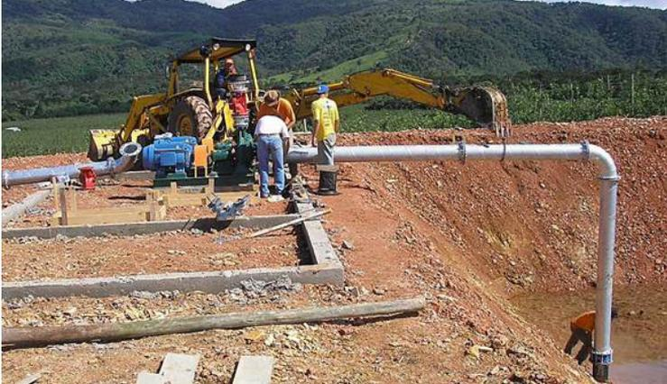
**Figura 117.** Detalhe da montagem da parte vertical da tubulação de sucção com a presença da válvula de pé com crivo. (Fonte: ANTUNES, 2006)
