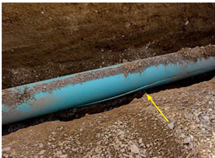
**Figura 11.** Detalhe de rompimento de uma adutora de PVC por esmagamento.
