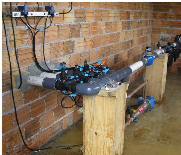
**Figura 109.** Detalhes de conexões de válvulas com controlador por tubos de controle.
