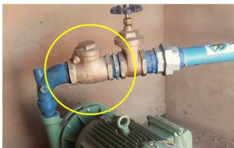
**Figura 98.** Exemplo de válvula de retenção instalada em uma adutora de irrigação. (FONTE: AGRONERI, 2015)
