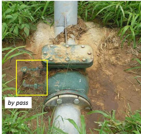
**Figura 122.** Válvula de retenção com destaque para o sistema *by pass*, instalada em uma linha de recalque de pivô central.
