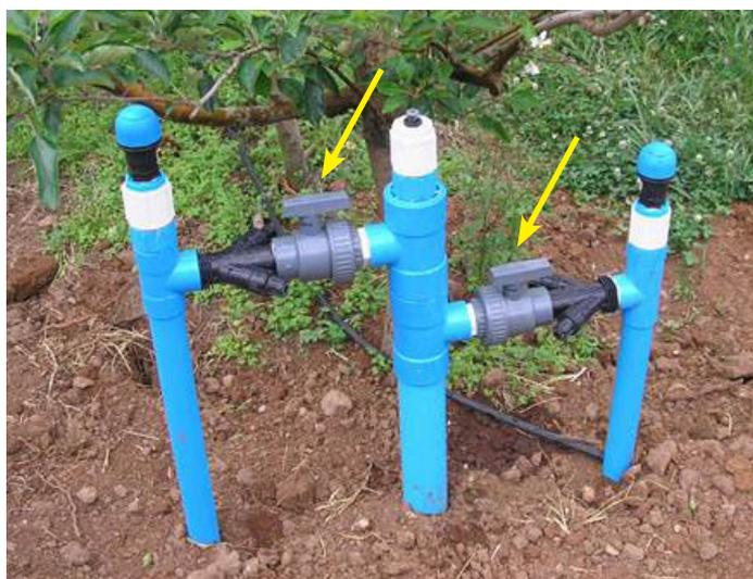
**Figura 72.** Exemplo de aplicação de válvula esfera em um cavalete de distribuição em irrigação por gotejamento. (Fonte: ANTUNES, 2006)
