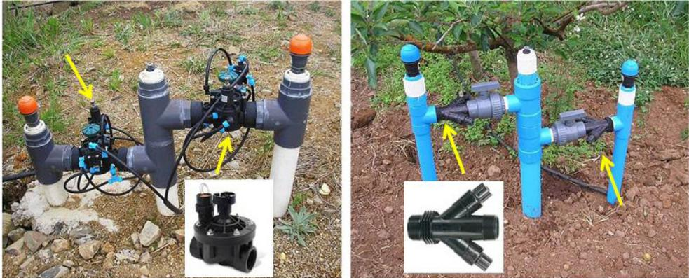
**Figura 87.** Detalhes de válvula reguladora de pressão em cavaletes de distribuição, sendo à esquerda com controle e à direita, válvulas de ação direta sem controle. (Fonte: ANTUNES, 2006)
