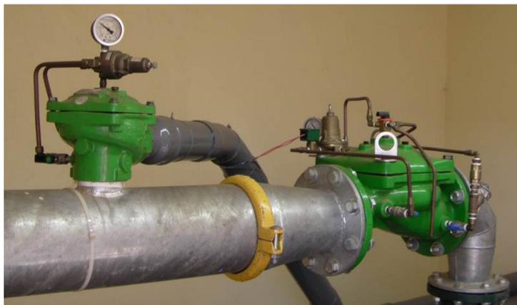
**Figura 4.** Exemplo de válvulas utilizadas em sistemas de controle e segurança em irrigação localizada.
