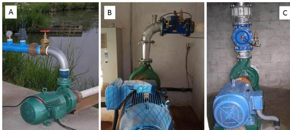
**Figura 120.** Exemplos de diferentes montagens do conjunto de bombeamento para bomba centrífuga. (Fonte: ANTUNES, 2006)
