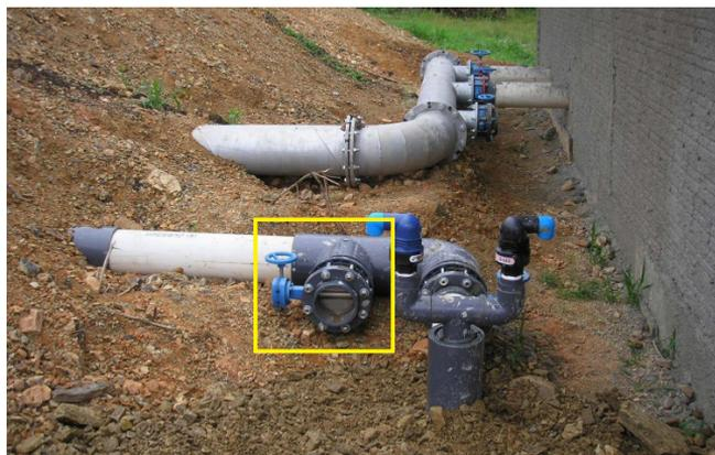
**Figura 74.** Exemplo de utilização de válvula borboleta na saída de sistema de bombeamento em irrigação. (Fonte: ANTUNES, 2006).
