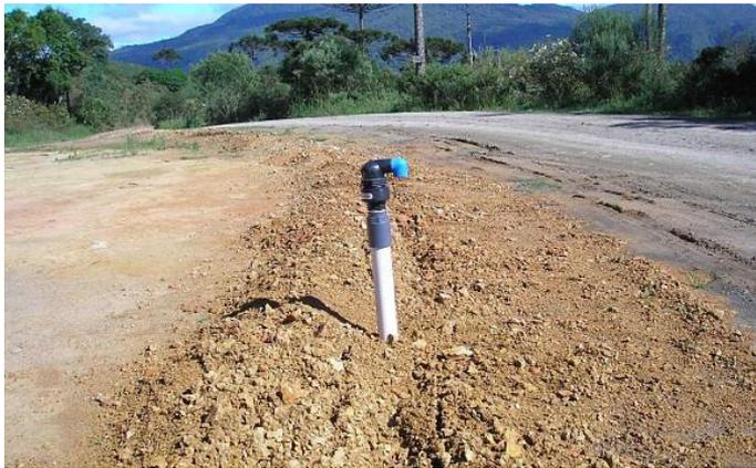
**Figura 124.** Exemplo de uma válvula ventosa instalada em uma linha de recalque enterrada.
