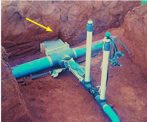
**Figura 129.** Detalhe da ancoragem de um cavalete de irrigação localizada, transmitindo a reação para a parede da valeta. (Fonte: LOPES, 2014)
