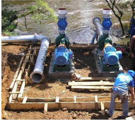
**Figura 115.** Detalhes do início da montagem de um conjunto motobomba. (Fonte: ANTUNES, 2006)
