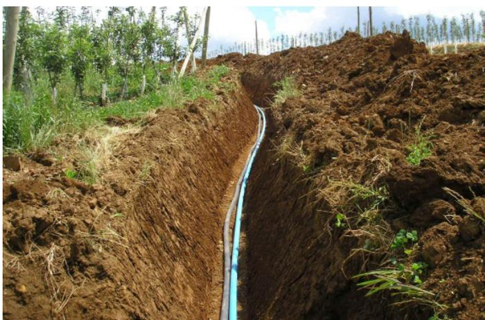
**Figura 127.** Exemplo de tubulação de recalque enterrada em irrigação localizada.
