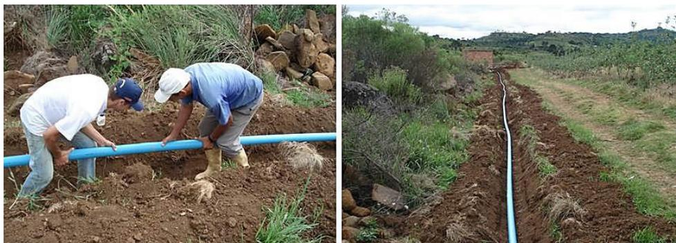
**Figura 131.** Tubulação adutora de PVC soldável sendo conectada e disposta em valeta rasa.
