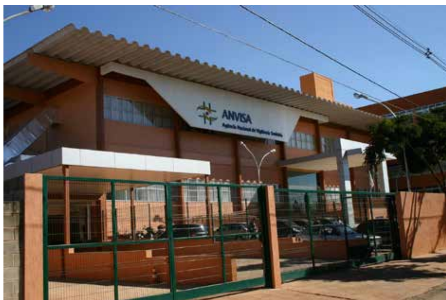
Figura 4: Sede da ANVISA em Brasília Fonte: Sede..., 2008.
