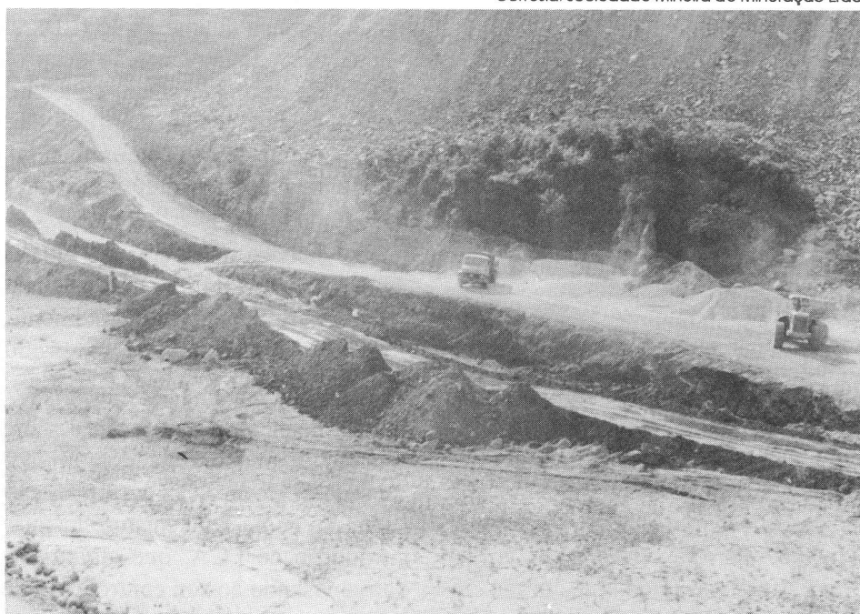
Mina de manganês do Morro da Mina, Conselheiro Lafaiete, MG: construção de drenagens para proteger o meio ambiente
